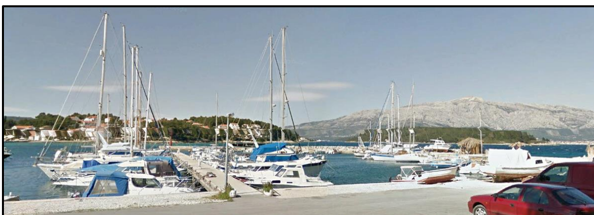
Slika 2.1-5. Postojeće stanje lokacije zahvata – pogled na gat 1
