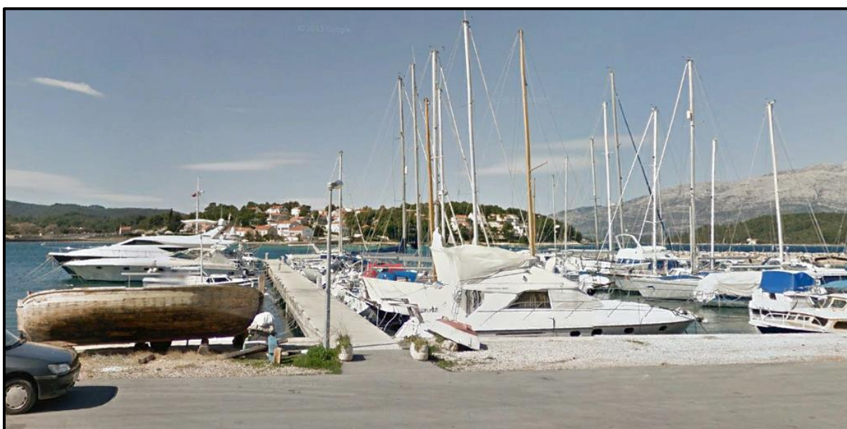
Slika 2.1-4. Postojeće stanje lokacije zahvata – pogled na gat 2 koji će se zahvatom produjiti
