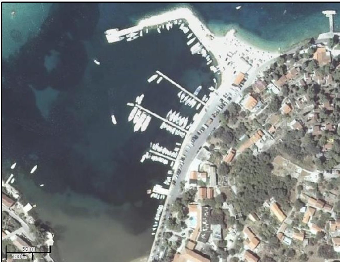
Slika 2.1-1. Postojeće stanje luke nautičkog turizma Lumbarda (izvor: Geoportal, 2018.)
